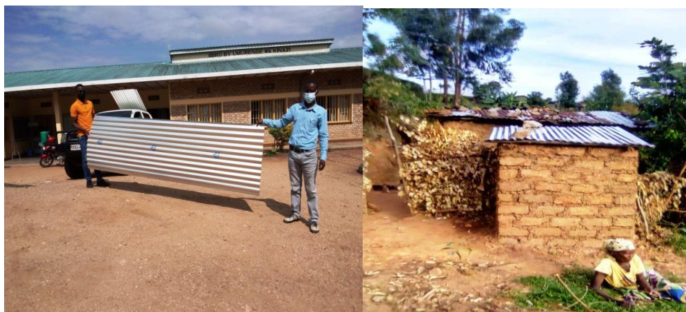
Photo de distribution au secteur et celle de latrine construite
