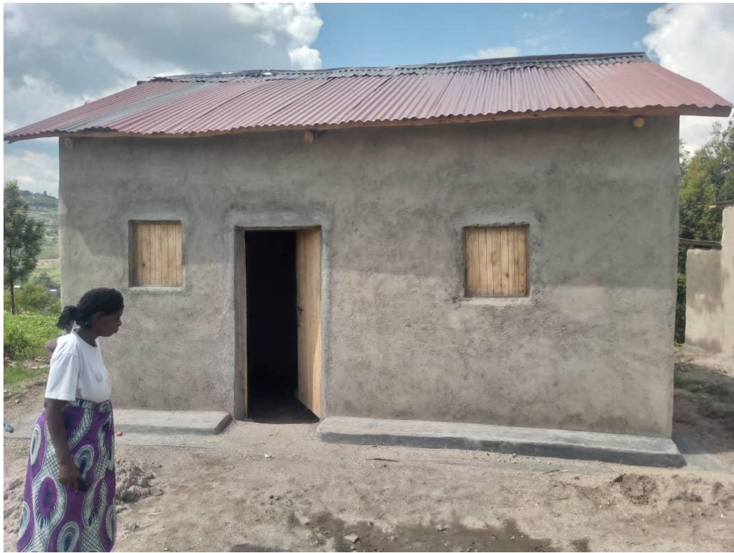
Maison de MUKANDAMAGE Geneviève
