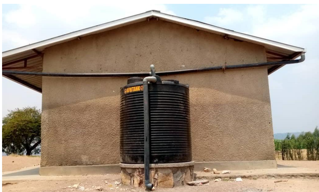
Installation des citernes à l'E.P Mugogwe
